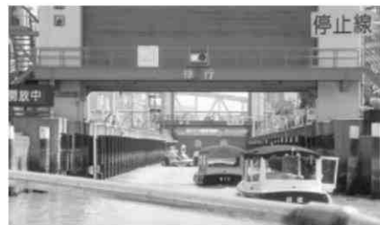
▲「扇橋こう門」前扉から入る
