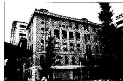
解体前の日本工業倶楽部ビル (99/11/3 筆者写す)
